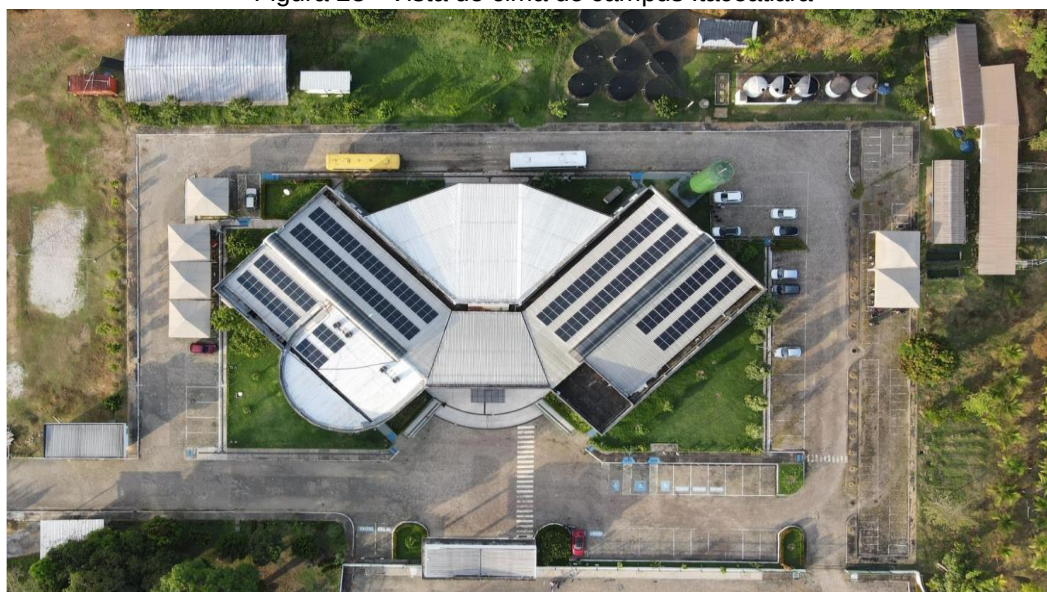
Figura 28 - Vista de cima do campus Itacoatiara
