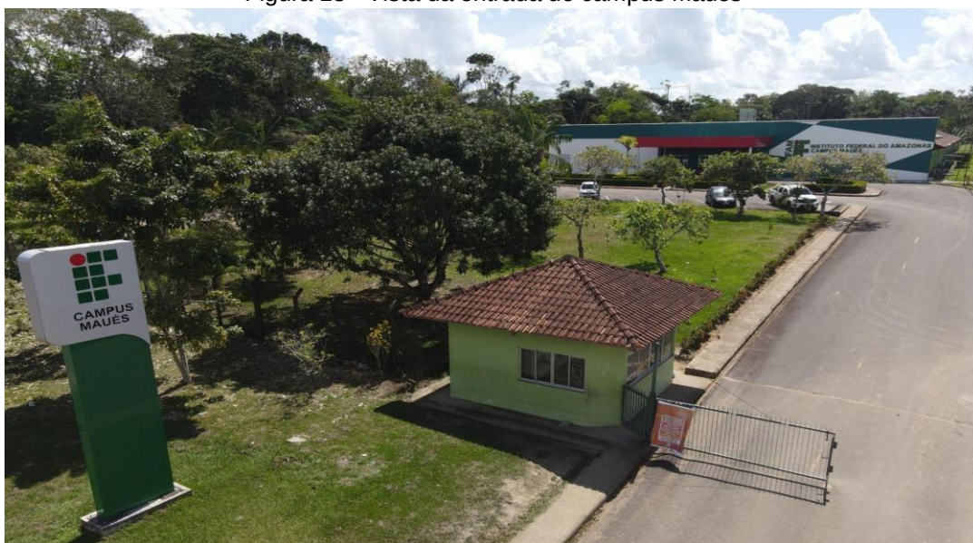
Figura 18 - Vista da entrada do campus Maués
