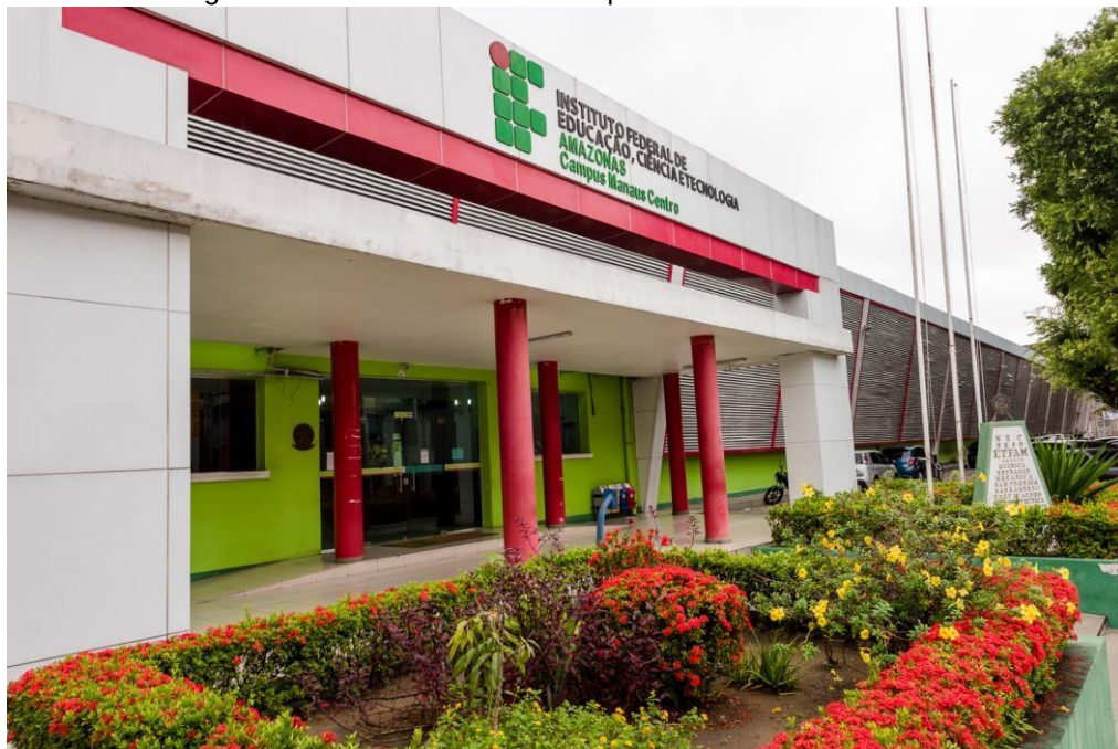
Figura 6 - Fachada atual do Campus Manaus Centro - CMC
