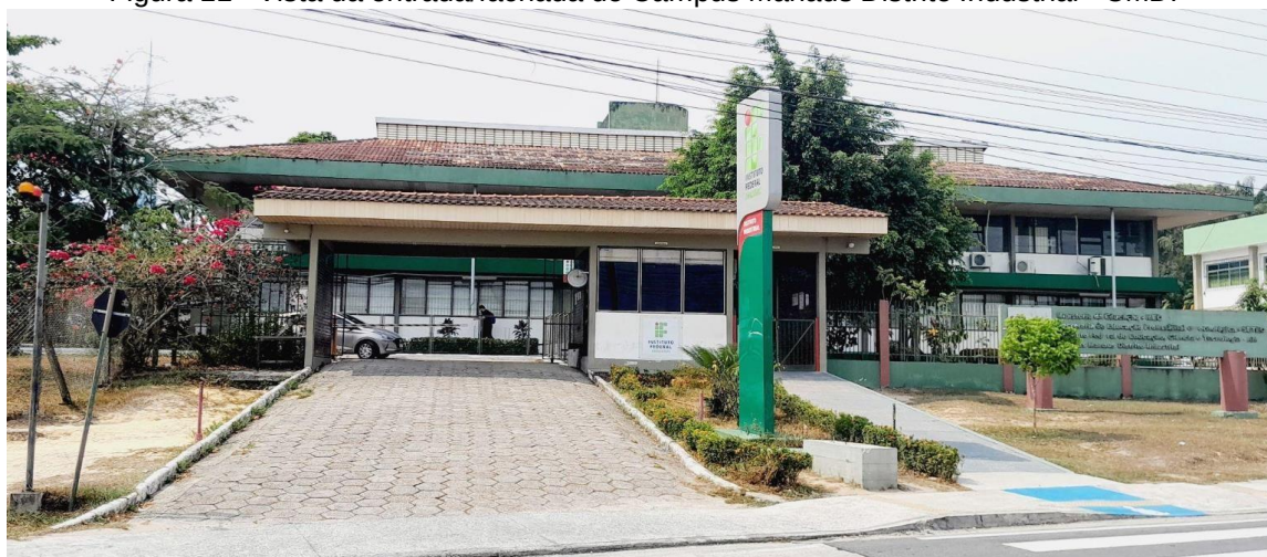
Figura 11 - Vista da entrada/fachada do Campus Manaus Distrito Industrial - CMDI
