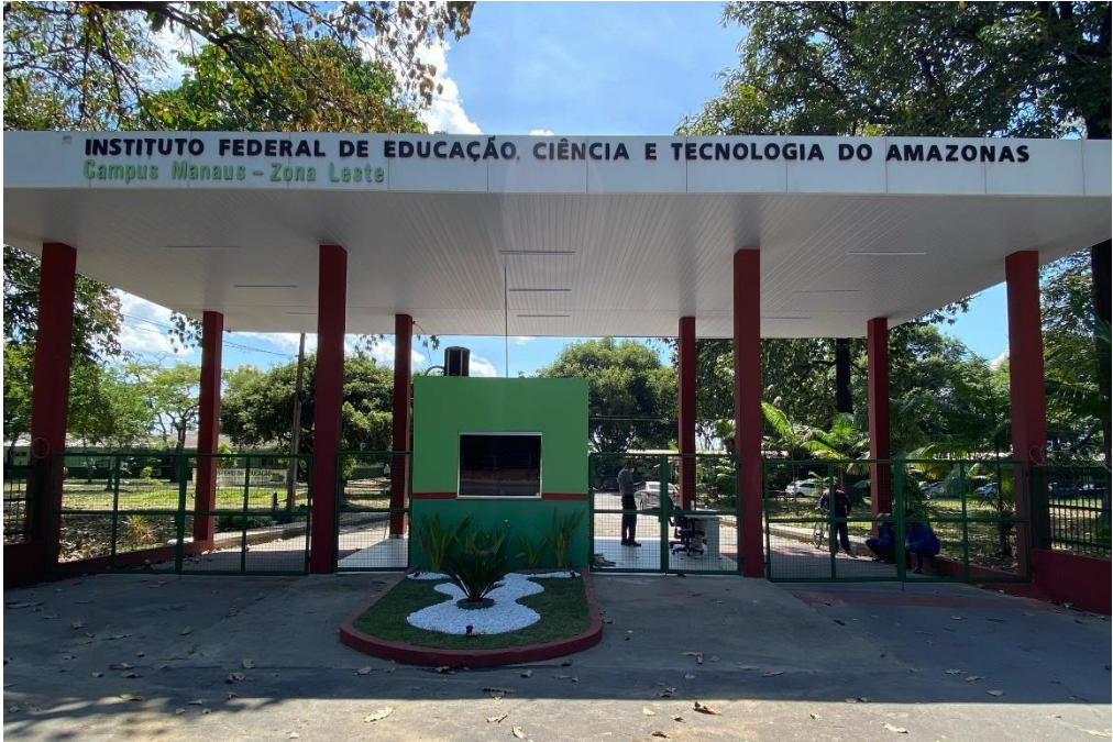
Figura 10 – Portaria principal de Entrada do campus Manaus Zona Leste
