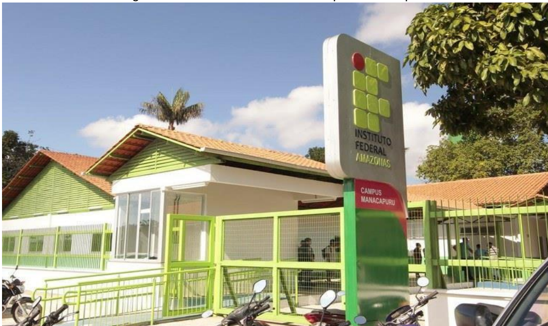
Figura 30 - Vista da entrada do campus Manacapuru
